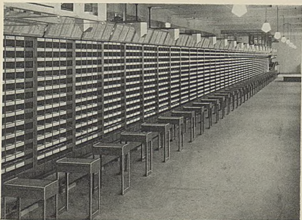
Briefverteilerwerk im Großbriefpostamt Berlin SW11.
