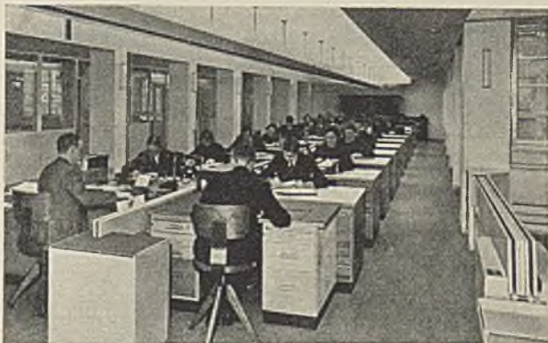
Hochkantverteiler-Förderbänder mit elektrisch gesteuerten Weichen im Versicherungskonzern Thule, Haus Centrum, Stockholm.
