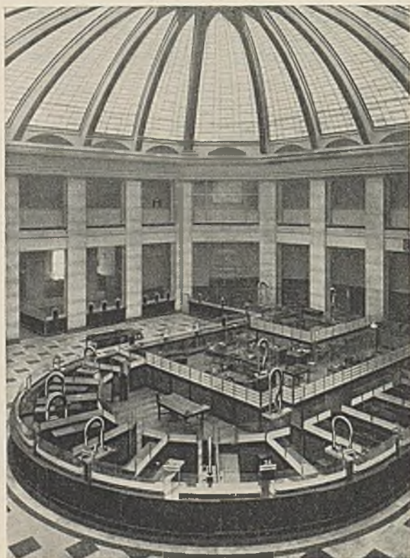
Rohrpost-Weichenanlage in der Schalterhalle der Banca Popolare, Mailand.
