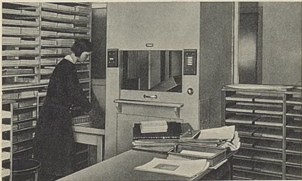
Aktenaufzug im Hochportenhhaus, Köln.
