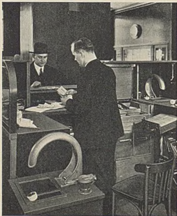
Rohrpost-Kleinanlage in einem Reisebüro.
