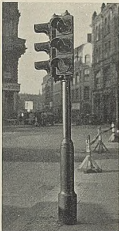
Zweiseitige Standampel (schiefwinklig).
