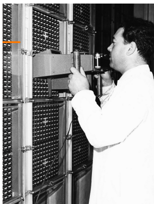
Relevé des compteurs ROTARY 7B1 de la Région Parisienne.
