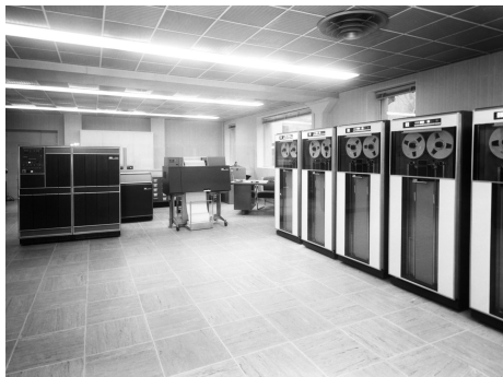
Calculateur IBM (série 1400) du Centre Régional de Comptabilité de Paris, avec des mémoires vives de tores magnétiques.
