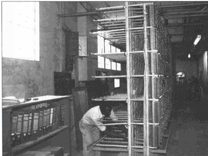
Travaux de réparation en cours au central téléphonique de Freetown
