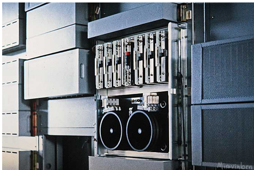
Photo d'une Machine Parlante équipant un Commutateur téléphonique Crossbar CP400.
