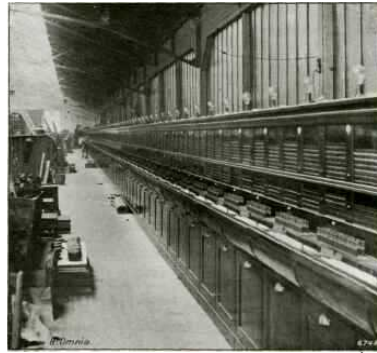
VUE D'ENSEMBLE DES GROUPES DE DÉPART PENDANT LE MONTAGE.
