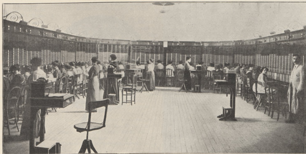
Fig. 1. — Vue d'ensemble d'un bureau central téléphonique manuel, à Paris.
