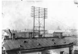
Ces constructions sur les toits ont été retirées après 1928.
