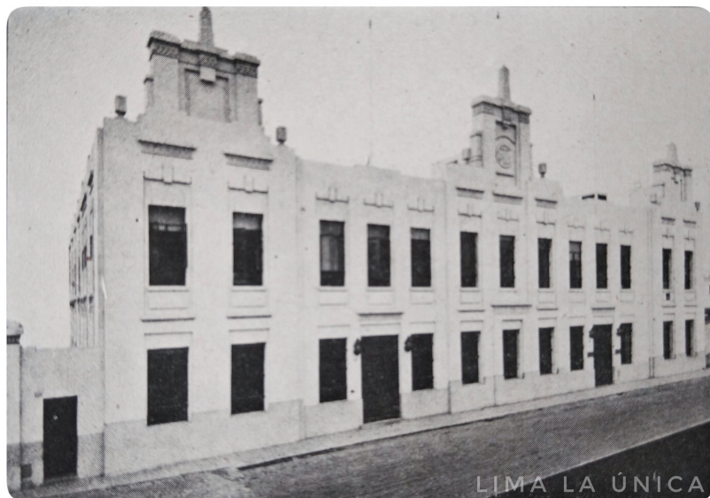
Lima : Ancien bâtiment du centre d'opérations de la compagnie péruvienne de téléphone situé dans la rue Washington. Aujourd'hui, à ce même endroit, il y a un bâtiment Movistar avec une grande antenne visible d'une bonne partie de Lima. Photo du milieu du XXe siècle
