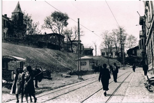
Kusdili Caddesi, le bâtiment du central téléphonique est visible sur la droite.
