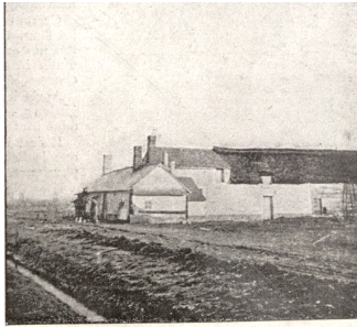
Le Marengo, poste d'expérience pour la téléphonie sans fil.
