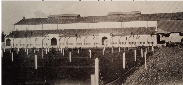
La cablerie de Maison-Carrée et le logement des cadres
