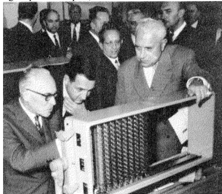
La photo montre un cadre de commutateur Pentaconta partiellement assemblé.
