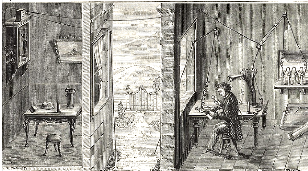
Fig. 1. Fig. 2. Disposition de l'installation adoptée en Italie pour l'étude des bruits souterrains au moyen du microphone.
