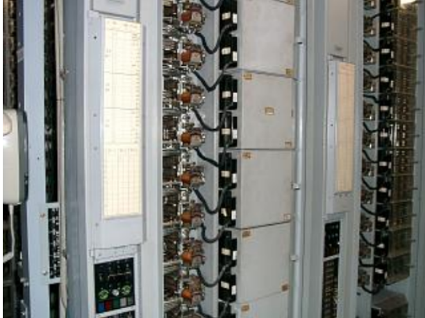
Fig. 7. Edelmetall-Motor-Drehwähler (EMD-Wähler) Sélecteur à moteur à contacts en métal rare
