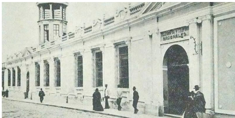
Bâtiment de la Direction générale des télégraphes et des téléphones en 1905
