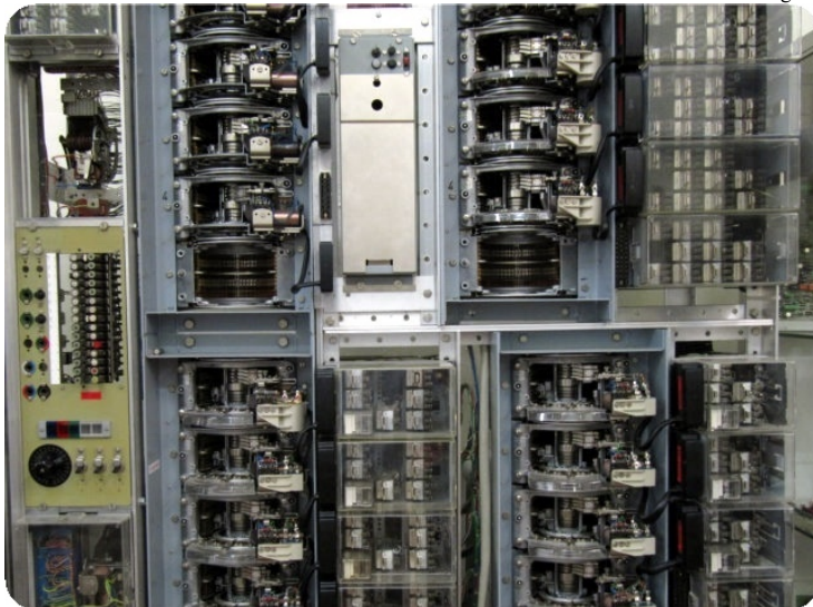
Cette photo montre une banque de sélecteurs conçue par Friedrich Merk dans les années 1920 et construite plus tard par la société « TN »
