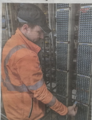
Chaque pièce en plastique, qui sont petit à petit retirées, représentent une habitation reliée à l'ADSL. IN L'ESQUET
