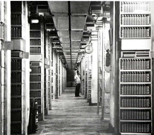
1951 Mise en servie de Abassia en matériel Ericsson ARF 102. Plan d'implantation Ericsson des différents systèmes autour du Caire.
