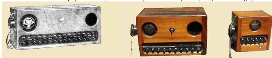
A gauche : Station principale à 15 touches, au centre : sous-station à 10 clés ou station exécutive, à droite : sous-station à 6 touches
