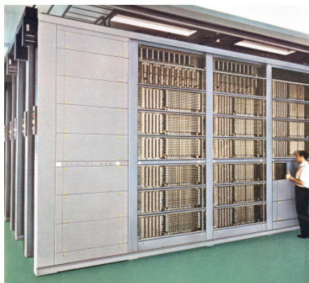
Suivra le PENTACONTA type 1000 A (Multisélecteur à 1040 points)
