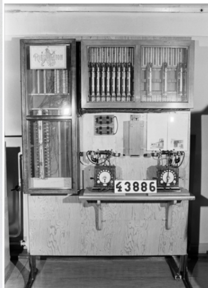
.Photo des sélecteurs de montée Betulander, année 1900. Stand de Hultman avec registre et inverseur de série pour 2000 abonnés. (regardez les cadrans spéciaux des téléphones)
