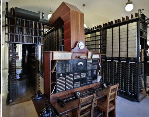
7A2 panneau de commande salle des machines. Centre 7A1 de budapest aujourd'hui musée.
