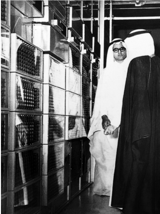
Un vieux centre téléphonique (PBX) de la ville de Riyad - 1961 (C'est un vieux système Strowger )
