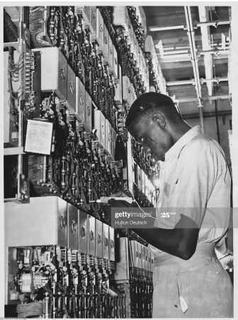
1950 Un homme au travail ajustant un sélecteur du central téléphonique automatique de Khartoum au Soudan
