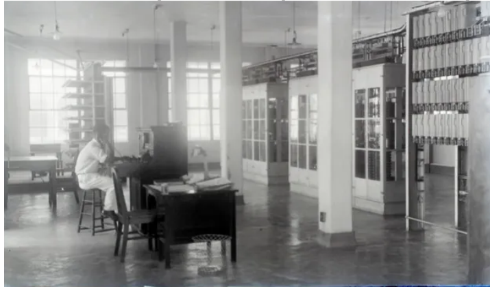
1929 Centrale du téléphone automatique à PauP; Bâtiment de préselecteurs et sélecteurs et table d'essai.
